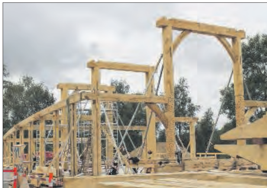
Kongehallen bliver 2,5 meter højere, når topåsen er monteret.
