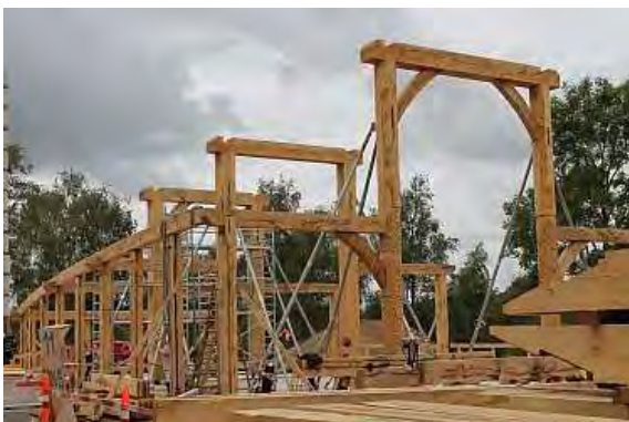
Kongehallen bliver 2,5 meter højere, når topåsen er monteret.
